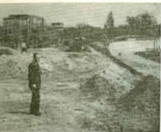
Budowa stadionu Cracovii 1965–1966
