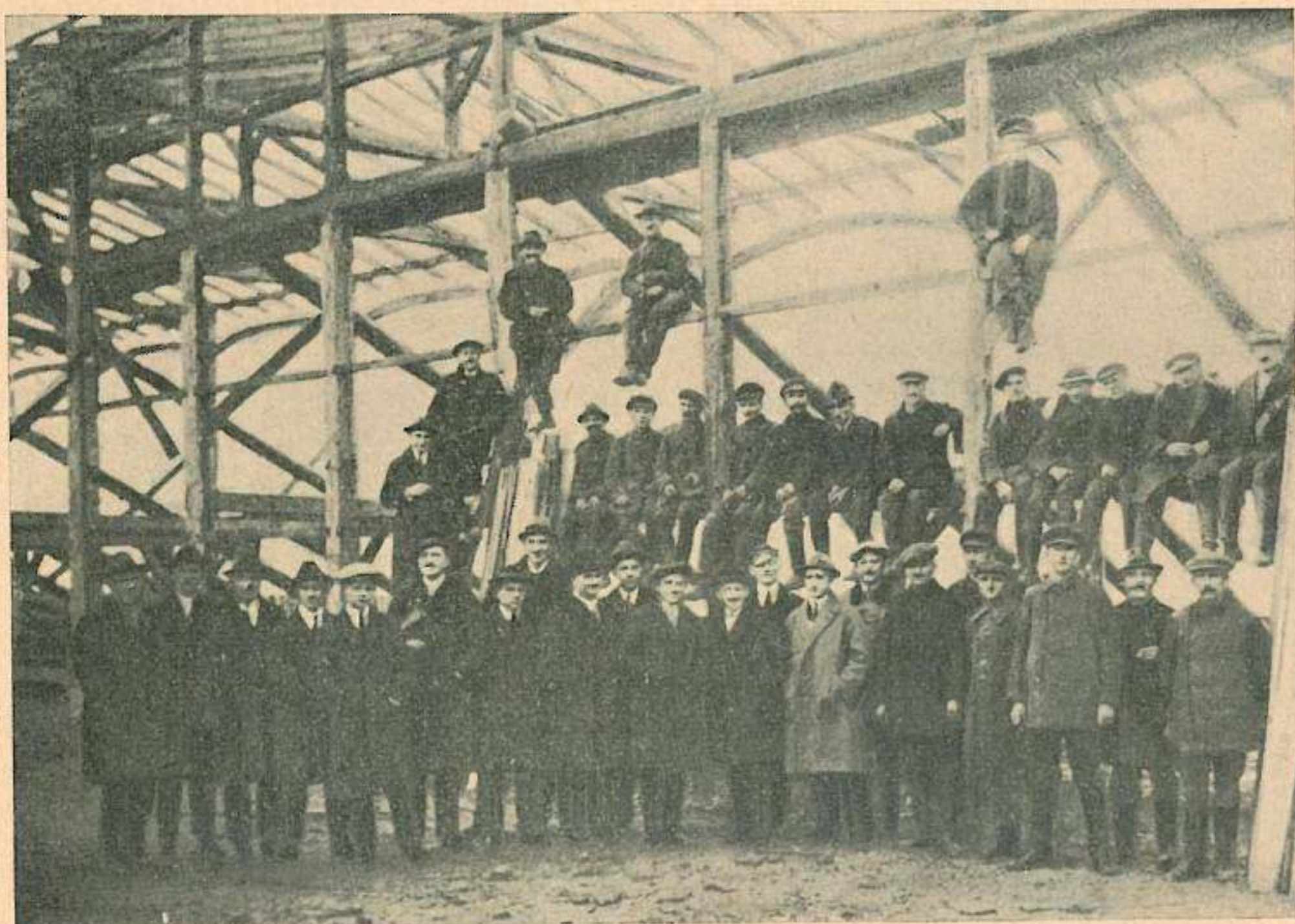
Trybuna Warty w trakcie budowy.
