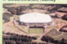
Stadion Arena "AufSchalke" w Gelsenkirchen, Niemcy
