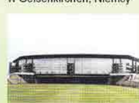
Stadion Arena "AufSchalke" w Gelsenkirchen, Niemcy
