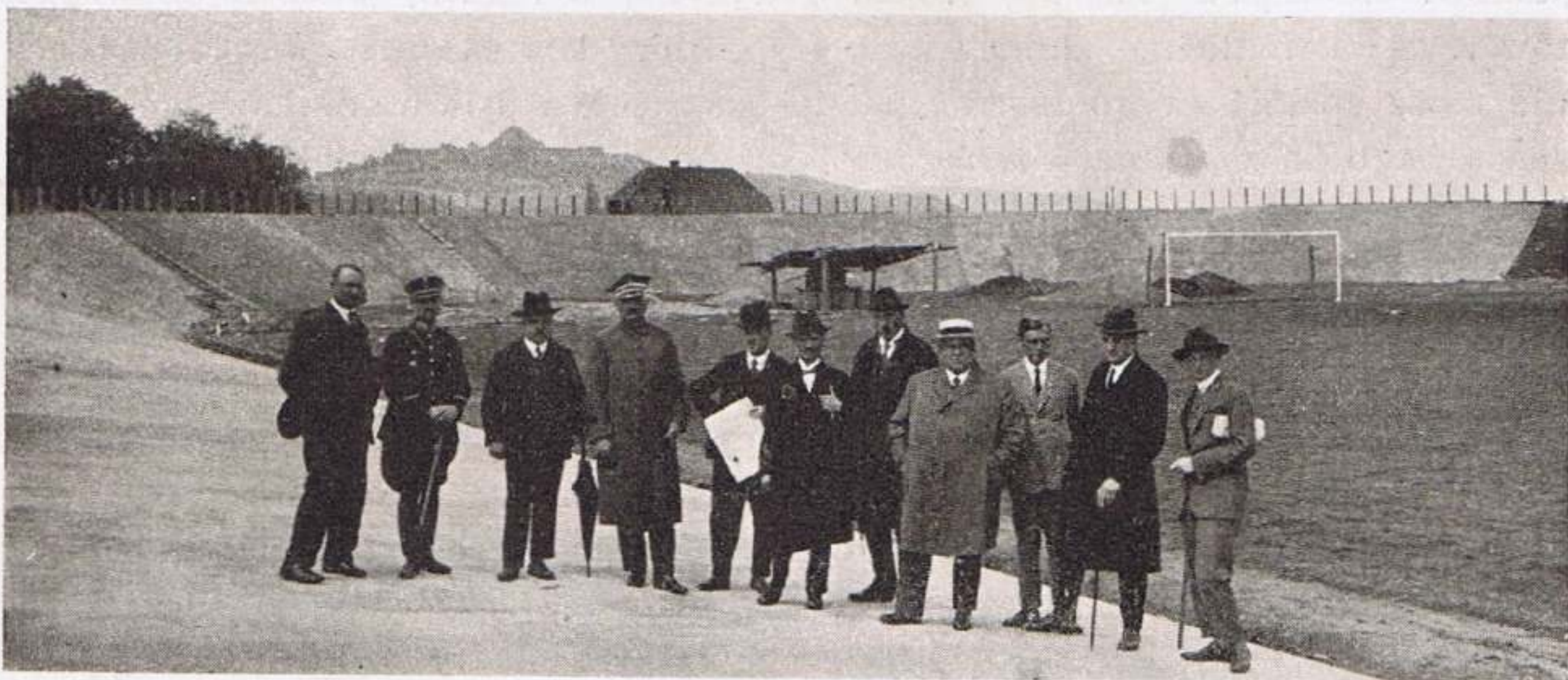
Członkowie komisji badającej stan robót przy budowie toru kolarskiego w parku gier K. S. „Cracovia“ (r. 1923).
