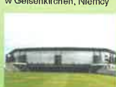
Stadion Arena "AufSchalke" w Gelsenkirchen, Niemcy
