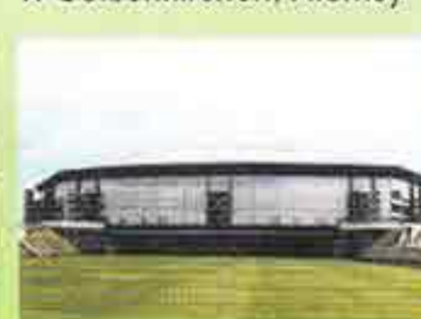
Stadion Arena "AufSchalke" w Gelsenkirchen, Niemcy
