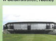
Stadion Arena "AufSchalke" w Gelsenkirchen, Niemcy
